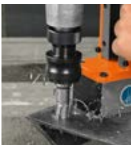
Perçage par carottage
