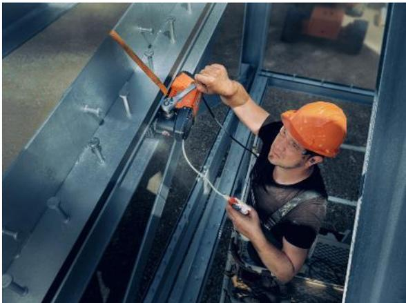
Bildunterschrift: Die MAGFORCE verfügt über ein Gesamtgewicht von lediglich 8,5 Kilogramm und ist deshalb sehr gut für Bohr- und Montagearbeiten auch über Kopf geeignet.
